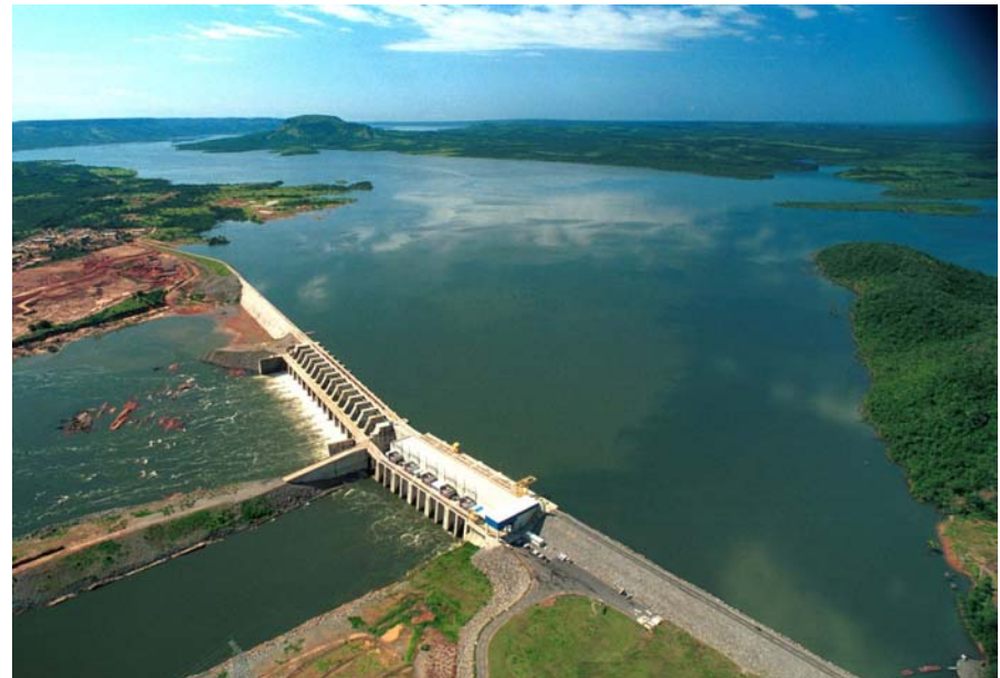
Ilustração 2 – Barragem e Reservatório - UHE Lajeado
